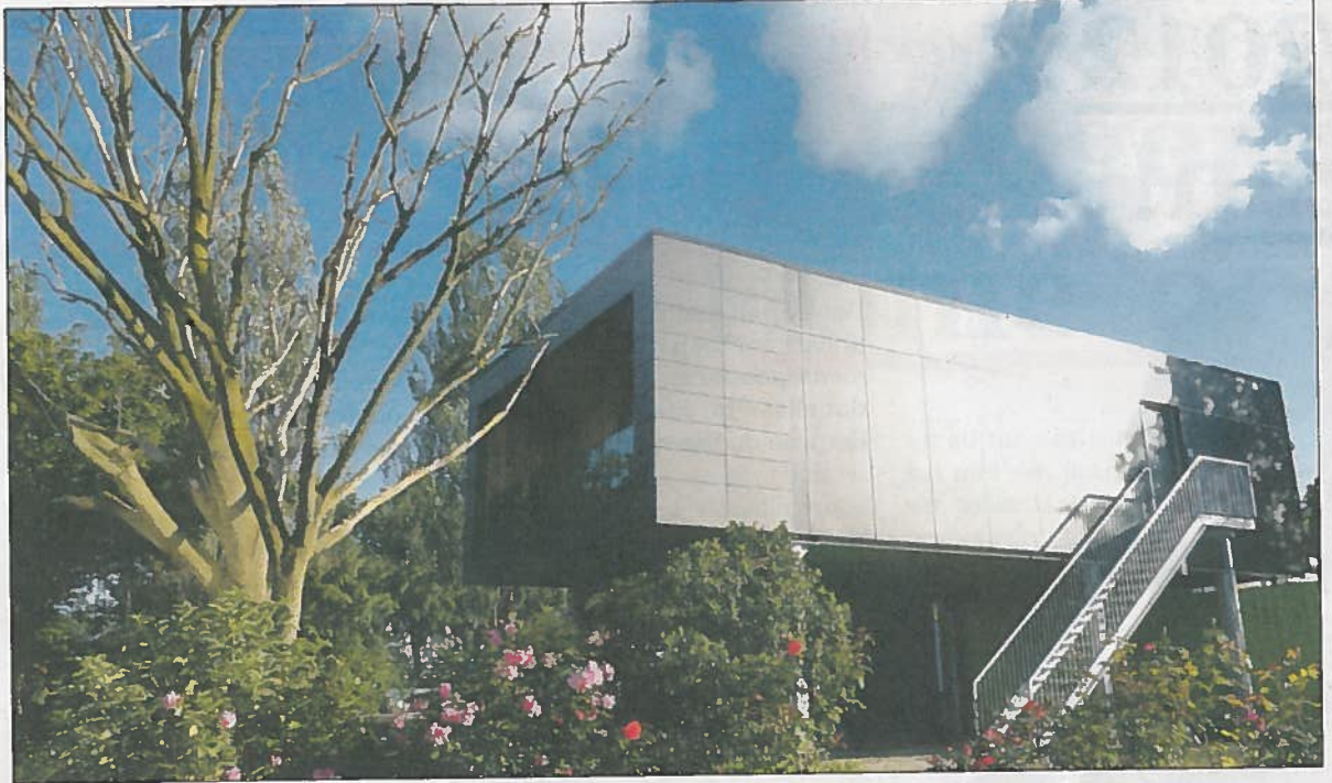
Het installatiewerk in het Concept House kan door slim prefab bouwen in een middag in elkaar worden gezet.
