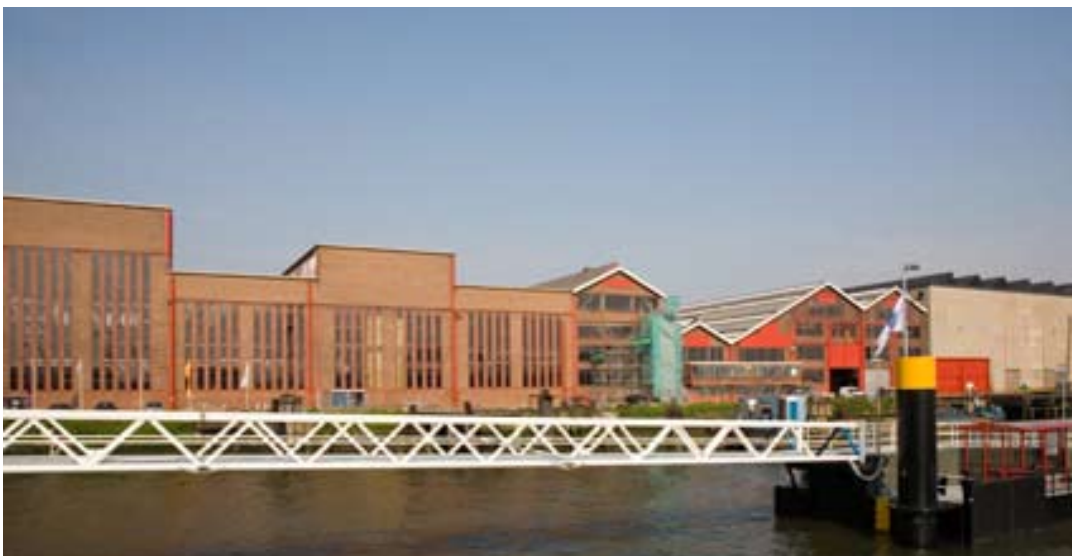
Binnenverbouwing van voormalige RDM machinehal tot RDM Innovation Dock, kassenbouw faciliteert leer/werkbedrijf van Hogeschool Rotterdam en het Albeda College. Het ontwerp is van Van Heerden & Partners Architecten.
